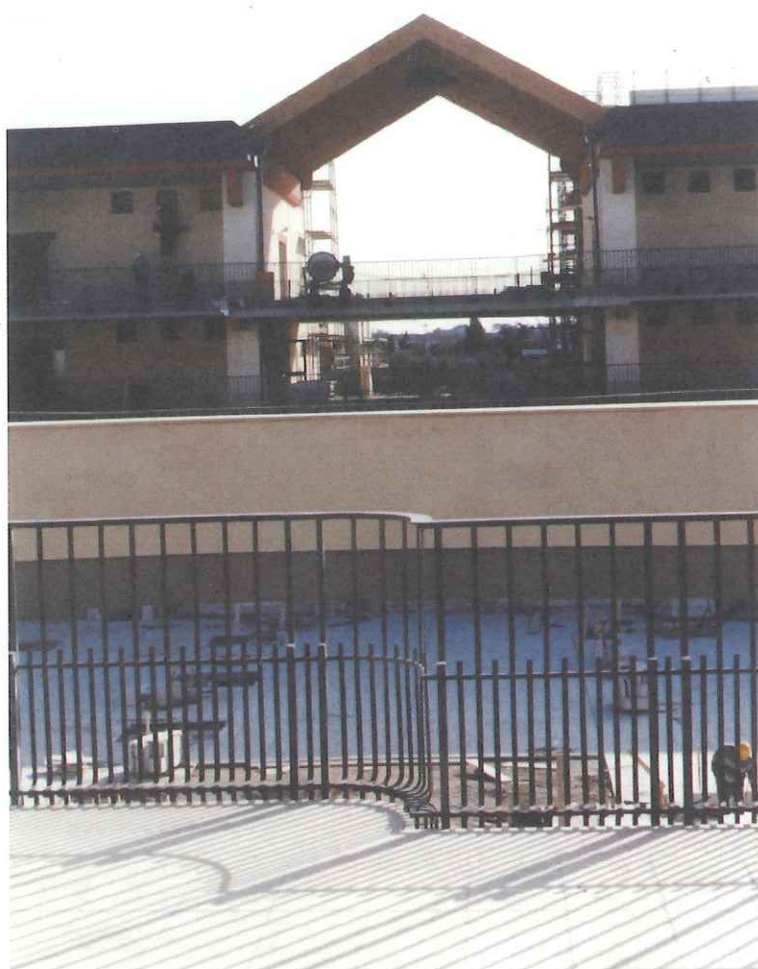
Ingresso alle aule
