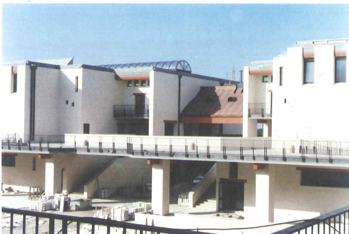
Complesso delle aule viste dalla "piazza della didattica"
