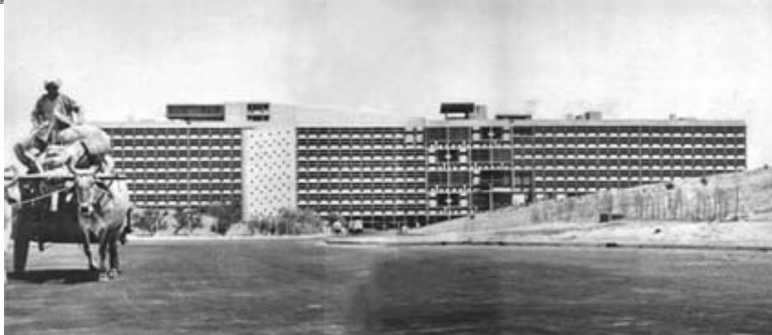
Il cantiere, i contrasti
